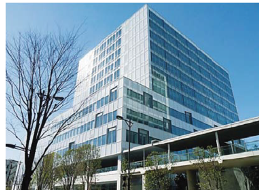
(完成した5号館)
