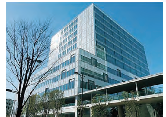
(完成した5号館)
